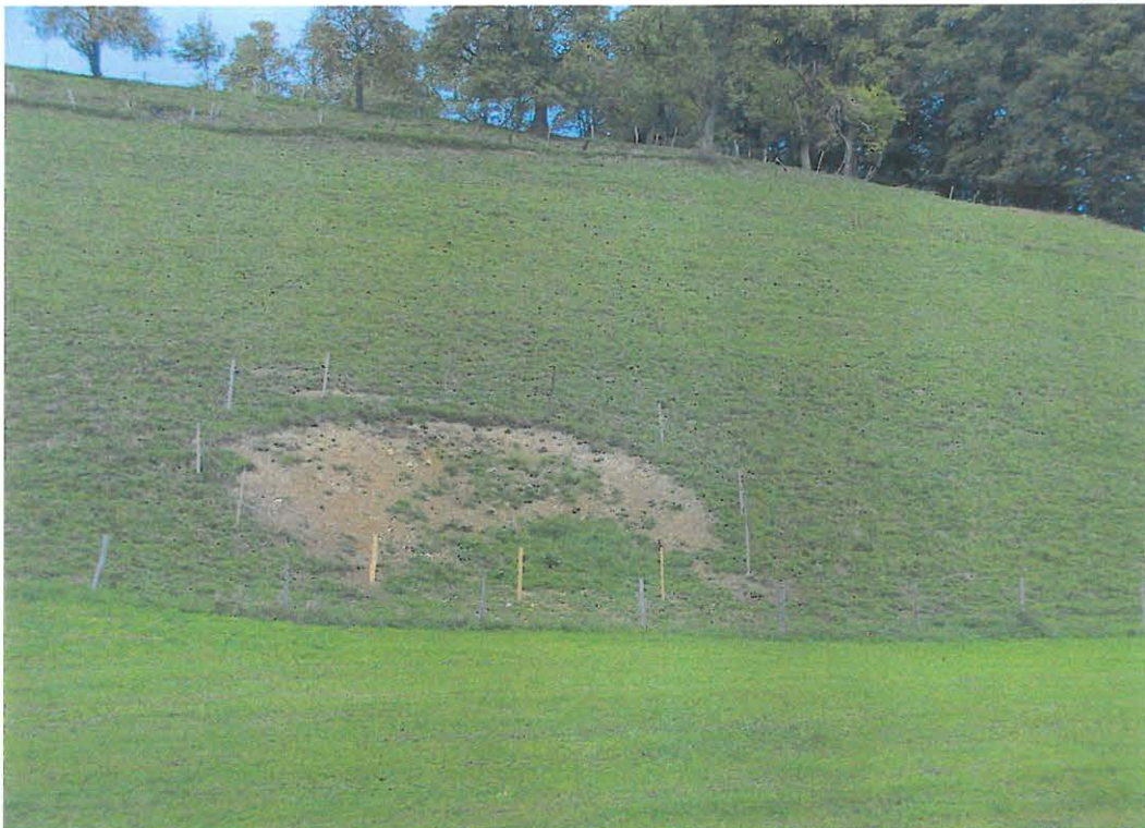
Abb. 2. Erosionsfläche im Weidebereich.
